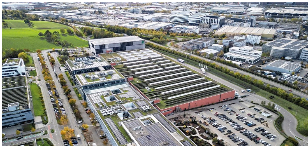
Die Bechtle Konzernzentrale in Neckarsulm punktet als nachhaltiger Standort: Über 7.000 Solarmodule auf allen verfügbaren Dachflächen, 261 Erdwärmesonden unterhalb der Büro- und Lagergebäude, Gebäudetechnik mit natürlichen Kühlmitteln oder 7.500 Quadratmetern Grünanlage. Copyright: Leo Dörfele
